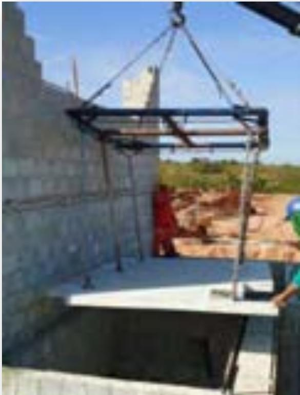
4) Lajes do pavimento já colocadas
