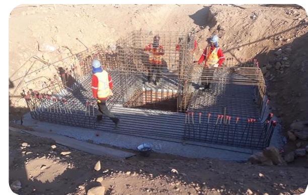
Execução da fundação da subestação de 230kV
