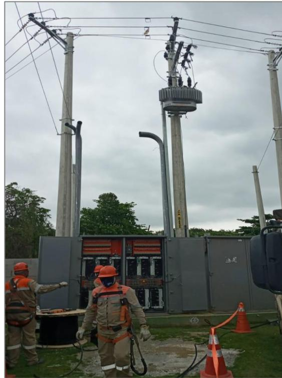
Instalação de equipamentos de medição nas caixas blindadas e conexões de clientes
